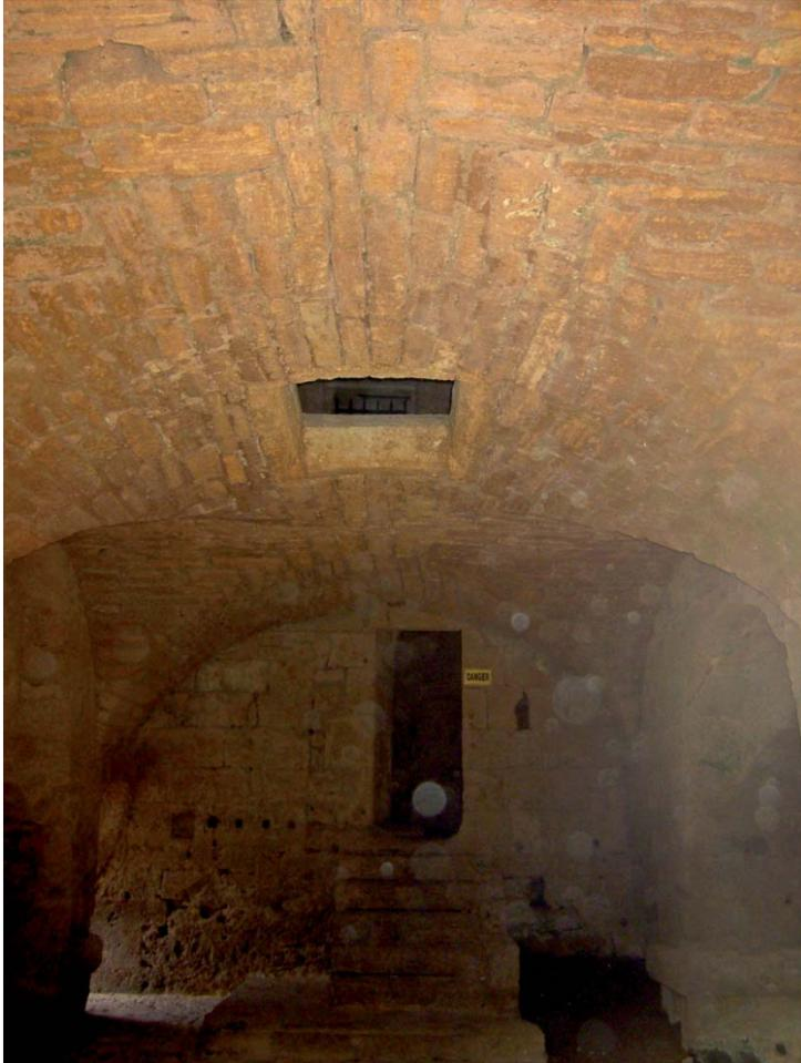
Vue de la salle où se trouvait le puits d'engrenage et le mécanisme du moulin. La voûte d'arrête, probablement construite au 17<sup>e</sup> siècle, a remplacé un plancher de bois.
