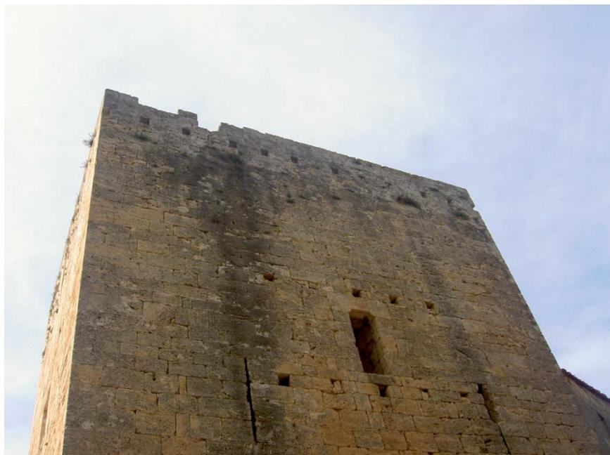
**On peut voir dans la partie haute la tour les trous servant à la fixation du hourdage de bois. Au dessus et au dessous de la porte, un ensemble de trou servait à l'ancrage de la structure de bois.**
